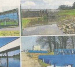
Le bassin rennais va être alimenté en eau potable par l'aqueduc Vaine Atlantique. Le projet est financé par le Département de l'Ille-et-Vilaine, le Morbihan et la Loire-Atlantique. Les travaux ont débuté en 2010. Il s'agit de la phase 2010, pour un coût total de 30 millions d'euros. Les travaux ont été réalisés en plusieurs étapes. Les deux plus grosses sections de 40 km de longueur ont été réalisées à la station de traitement des eaux de Forêt (barrage d'Arzal) à celle de Vilaines à Rennes. Cet ouvrage permettra un double service de circulation de l'eau. L'eau d'Ille-et-Vilaine rejoint aux plus de bassins estuaires de la côte sud. En sens inverse, l'eau d'Arzal offre une meilleure recharge hivernale et préliminaire des ressources en eau d'Ille-et-Vilaine. « Grâce au raccordement à Rennes, véritable rocade hydraulique du département, cette conduite vient compléter l'ensemble du département, à l'exception de la Côte d'Armor », explique Jean-Pierre Troussard. Un volume d'eau potable supplémentaire de 7 millions de m 3 par an, soit 15 % des besoins actuels, permettra de faire face au développement du département, sans qu'aucun incident climatique.
