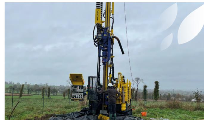
Foreuse en place pour le nettoyage du Forage de Linquenniac par broissage en rotation - CC Bretagne Romantique Travaux réalisés par l'entreprise Aquassys © SMG Eau 35
